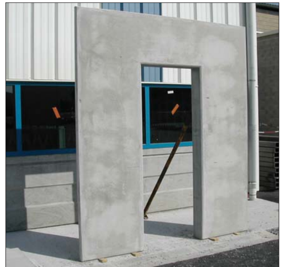
Coffrage avec chant en béton de fibre
