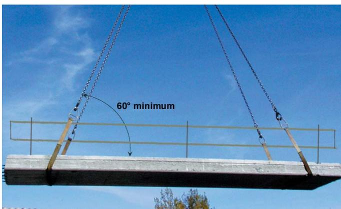
Les dalles ou les éléments démodulés (de moins de 1.20 m de largeur) peuvent être mis en place avec des sangles ou des chaînes ceinturant la dalle.
