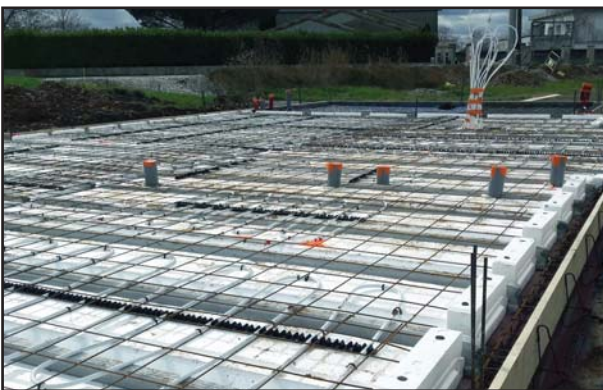
5 Pose des panneaux treillis soudés
