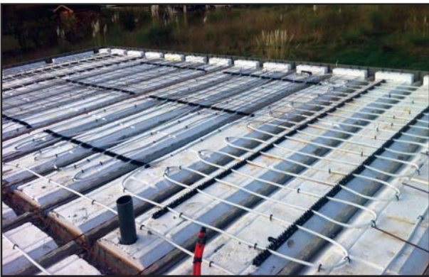
3 Pose des circuits chauffants
