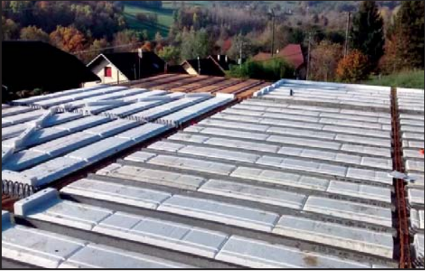
1 Pose du plancher Seacwatt
