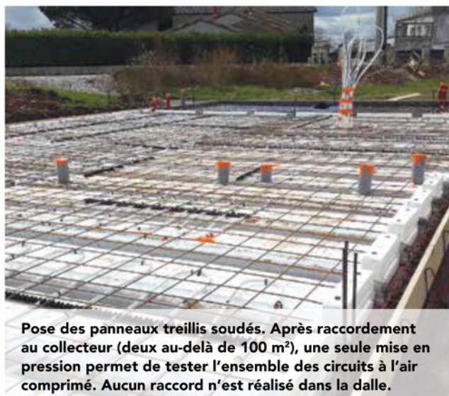
Après le traçage des repères de départ des circuits (inutile de matérialiser les cloisons), des rails de fixation sont agrafés. Puis les rouleaux de tube de chauffage sont déroulés et agrafés. Un kit de gaines de chauffage est réalisé sur mesure pour chaque pièce.
