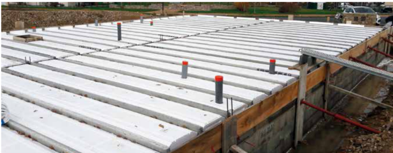
Pose du plancher Seacwatt : les réseaux eau et électricité sont traités en plenum.
